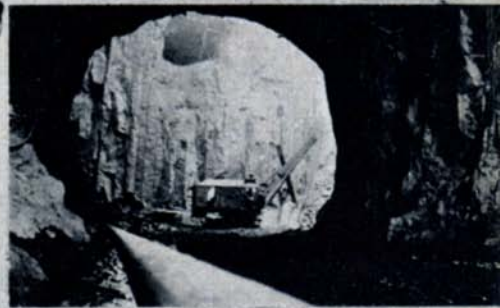
Усть-Хантайская ГЭС. Машинный зал вырубают в скале. Начальник стройки В. М. Плотников. Шофер Борис Иванов автор песен на звуковой странице.
